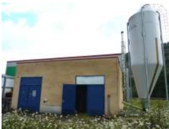
La chaufferie et son silo extérieur
