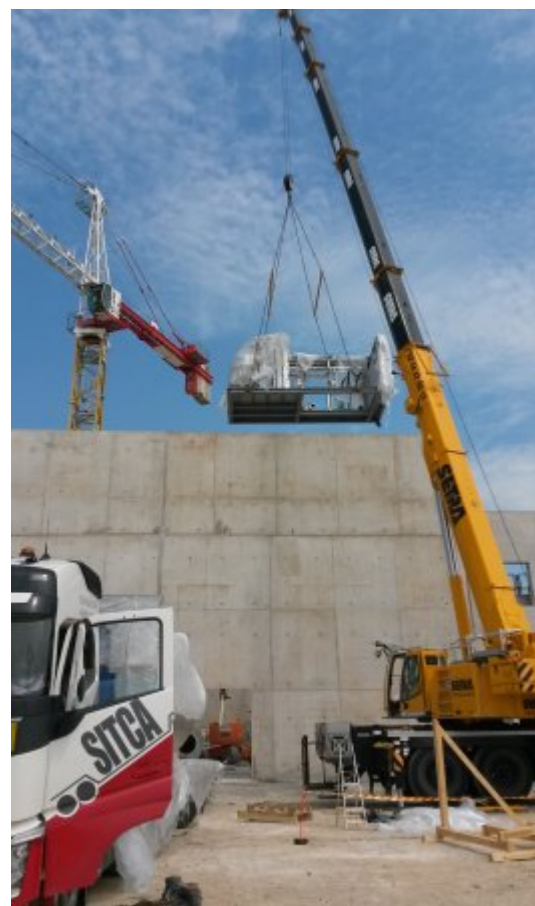
Grutage de la plateforme du laveur-condenseur à Joué-lès-Tours, photo Caligo
