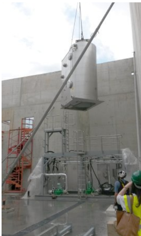
Assemblage de la tour de condensation sur la plateforme du laveur-condenseur à Joué-les-Tours, photo Caligo
