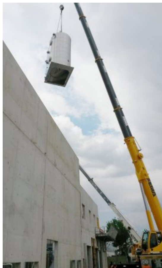
Grutage de la tour de condensation à Joué-les-Tours, photo Caligo
