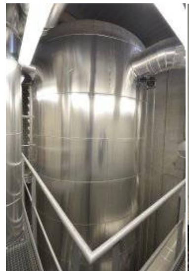
Le ballon d'accumulation de 95 m<sup>3</sup> permet d'écrêter les besoins de la chaufferie, photo FD
