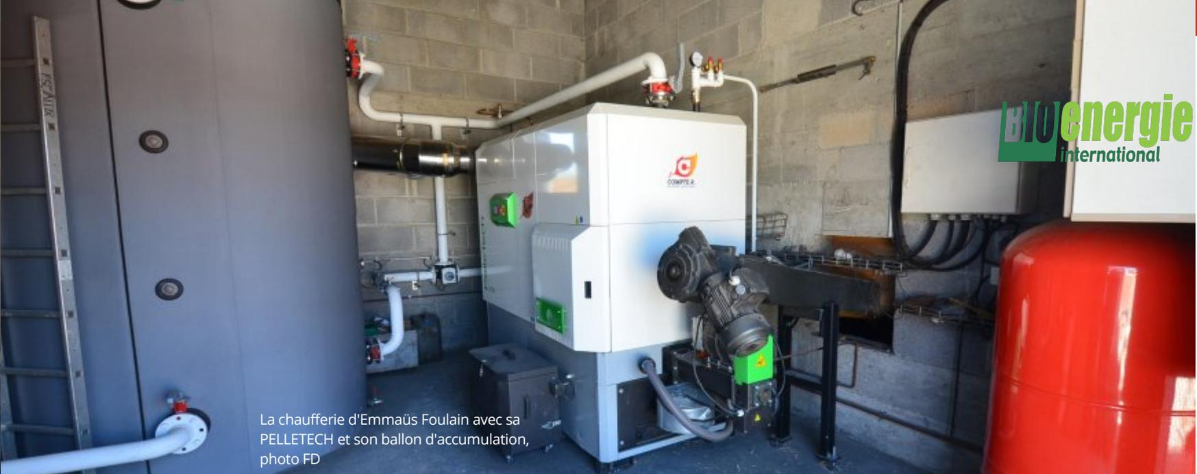
La chaufferie d'Emmaüs Foulain avec sa PELLETECH et son ballon d'accumulation, photo FD
