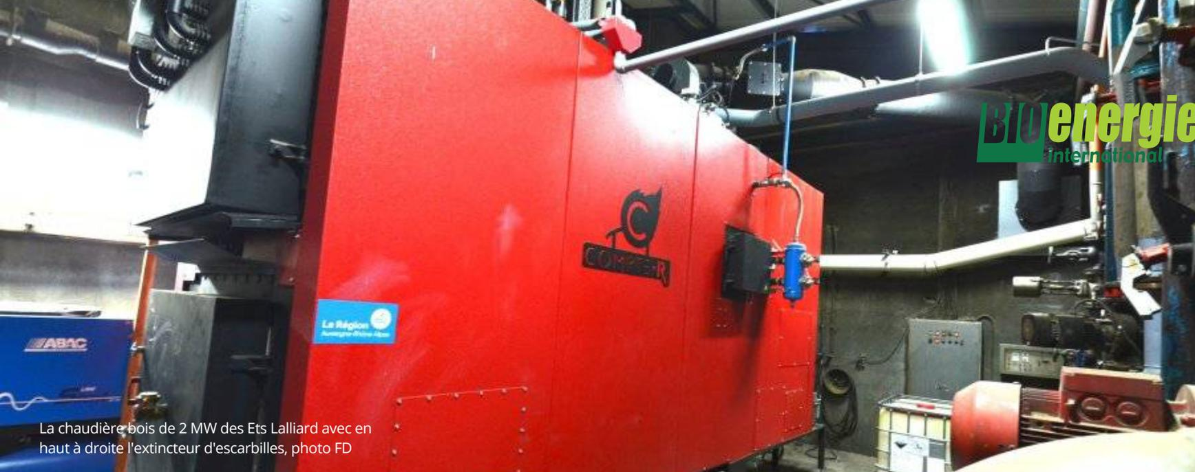
La chaudière bois de 2 MW des Ets Lalliard avec en haut à droite l'extincteur d'escarbilles, photo FD
