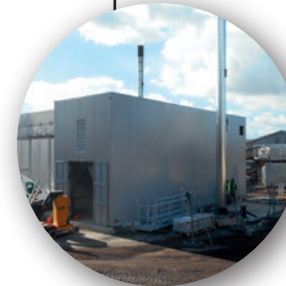
Conteneur chaudière L x l x h : 14 x 4,4 x 5,9 m
