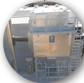
Traitement des fumées Electrofiltre - rejets <20\text{mg/Nm}^3
