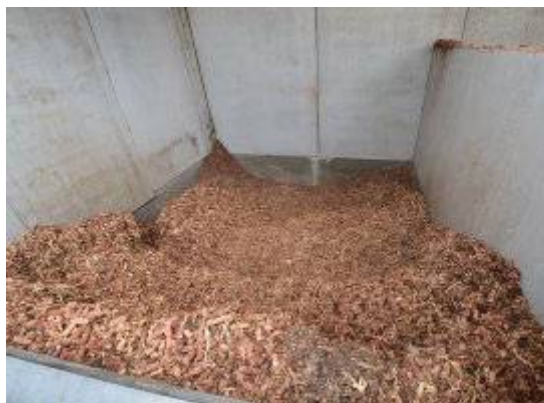
La fosse de livraison de la rafle de maïs à la chaufferie du Wacken, photo FD
