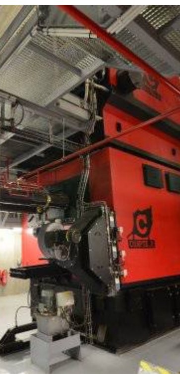
La chaudière Compte R. à rafle de maïs et sa trémie de dosage à la chaufferie du Wacken, photo FD
