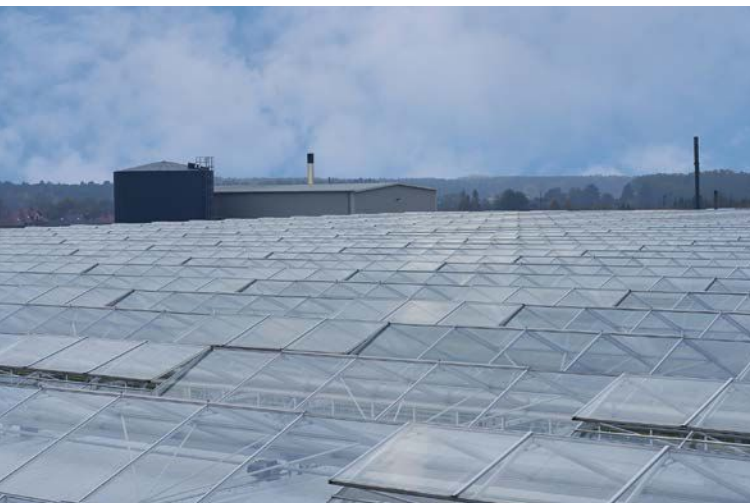
► Zrębki drzewne są obecnie najtańszym paliwem, przy wykorzystaniu dobrego pieca można nimi ogrzewać duże obiekty
