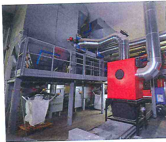
Les filtres à particules des deux chaudières à bois, cycloniques à droite et à manches à gauche, photo FD
